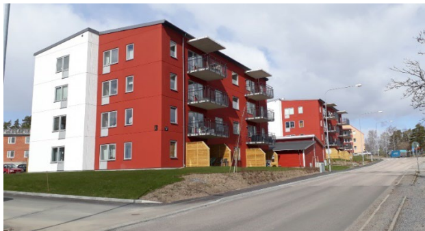
Längs med Hagbyvägen har K-fast byggt 2 hus med totalt 32 nya hyreslägenheter.
